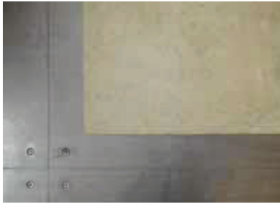
Figura 1: Ubicación de una loseta de 450 x 450 mm, que debe ser compensado por 75 mm a cada lado de un panel de piso elevado
